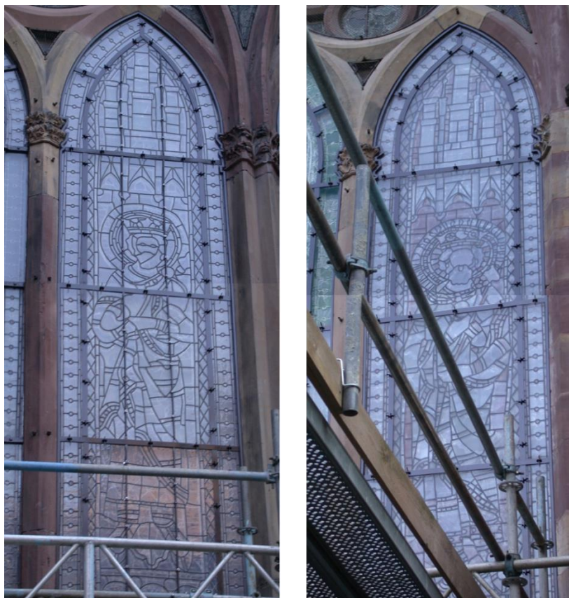
Fig. 1. Strasbourg, cathédrale Notre-Dame, prototype des verrières de protection, à gauche en verre mis en plomb et à droite en verre thermoformé. © LRMH, Claudine Loisel, 2005.
